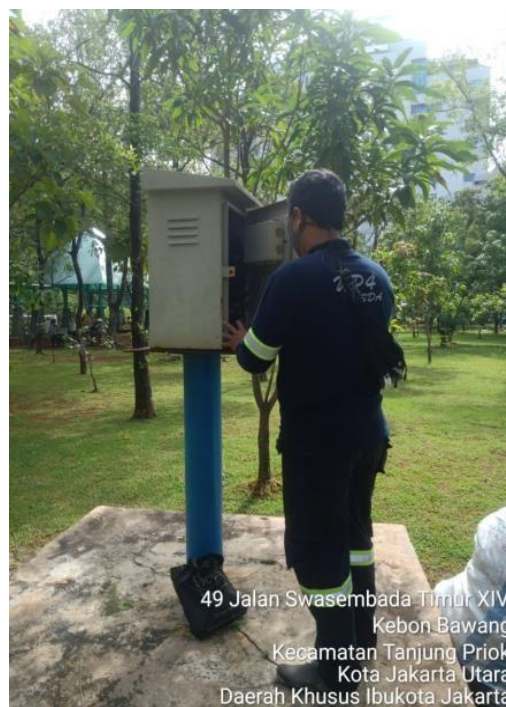
Gambar 1. Lokasi Pemasangan software Automatic Monitoring System (SAMS) di Sumur Pantau yang Akan Dimonitoring
